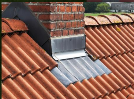
5 Overgang på skorsten
